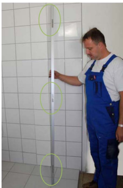
Fäst 3st montagebrickor per profil
