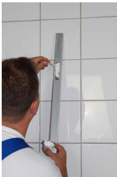
Efter rengöring av vägg och brickor belägg brickorna med lim och accelerator.
