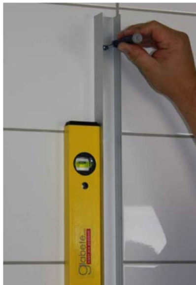
Efter att limmet har fått härda ca 5 timmar, montera fast profilen mot brickorna igen. Lätt uppvärmning med värmepistol accelererar härdningsprocessen ytterligare.
