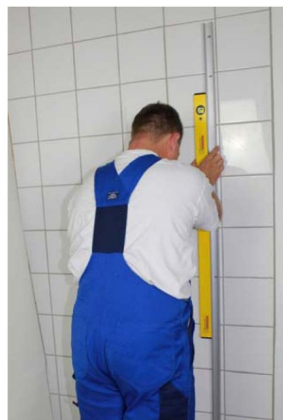
Märk ut och tryck fast profilen mot väggen (håll i några sekunder) Kontrollera att profilen sitter i lod.
