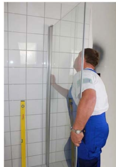
Därefter montera duschglaset i väggprofil, justera samt fixera glaset. KLART!
